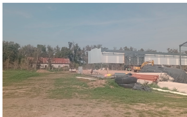
Vista de la ex Estación Sucre desde el Centro Ambiental (a la derecha, obras correspondientes a espacios de separación de reciclables y áreas administrativas)
